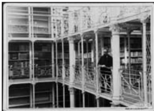
Los depósitos de la BNE obra del herrero Bernardo Asins y Serralta. Aspecto original del gran depósito de siete pisos de la BNE Bernardo Asins y Serralta (1897+)
