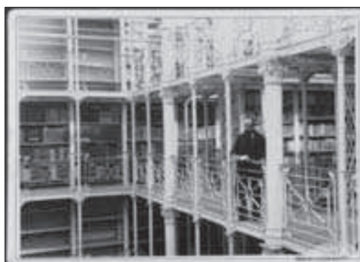
Los depósitos de la BNE obra del herrero Bernardo Asins y Serralta. Aspecto original del gran depósito de siete pisos de la BNE Bernardo Asins y Serralta (1897+)
